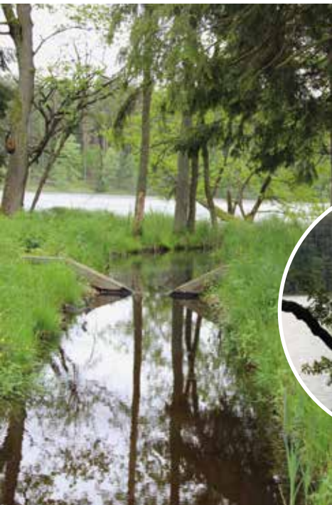
Obiekt małej retencji między jeziorem Oczko a łąką ↓
