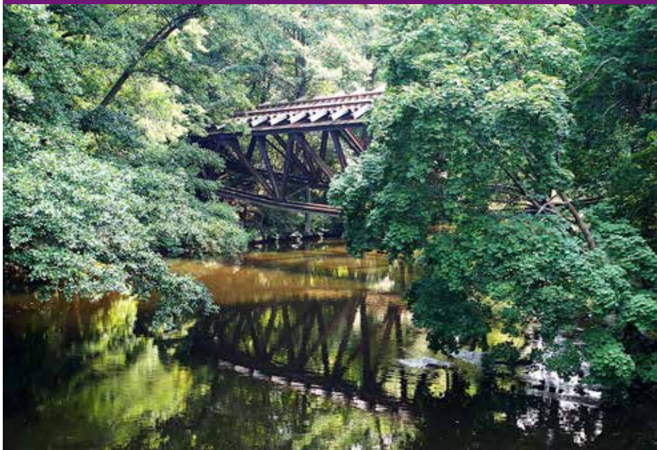
Zniszczony most kolejowy na Gwdzie w Jastrowiu
